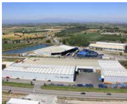
Fábrica 3 ubicada en Bellpuig (Lleida).
