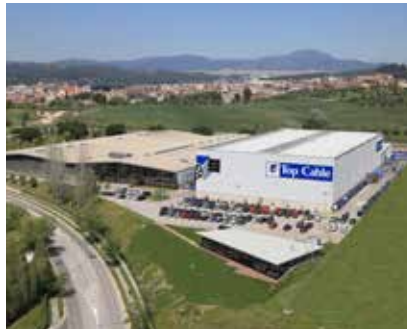
Fábrica 1 y Centro Logístico Robotizado ubicados en Rubí (Barcelona).
