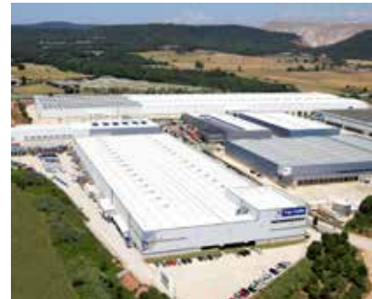
Fábrica 2 ubicada en Sallent (Barcelona).
